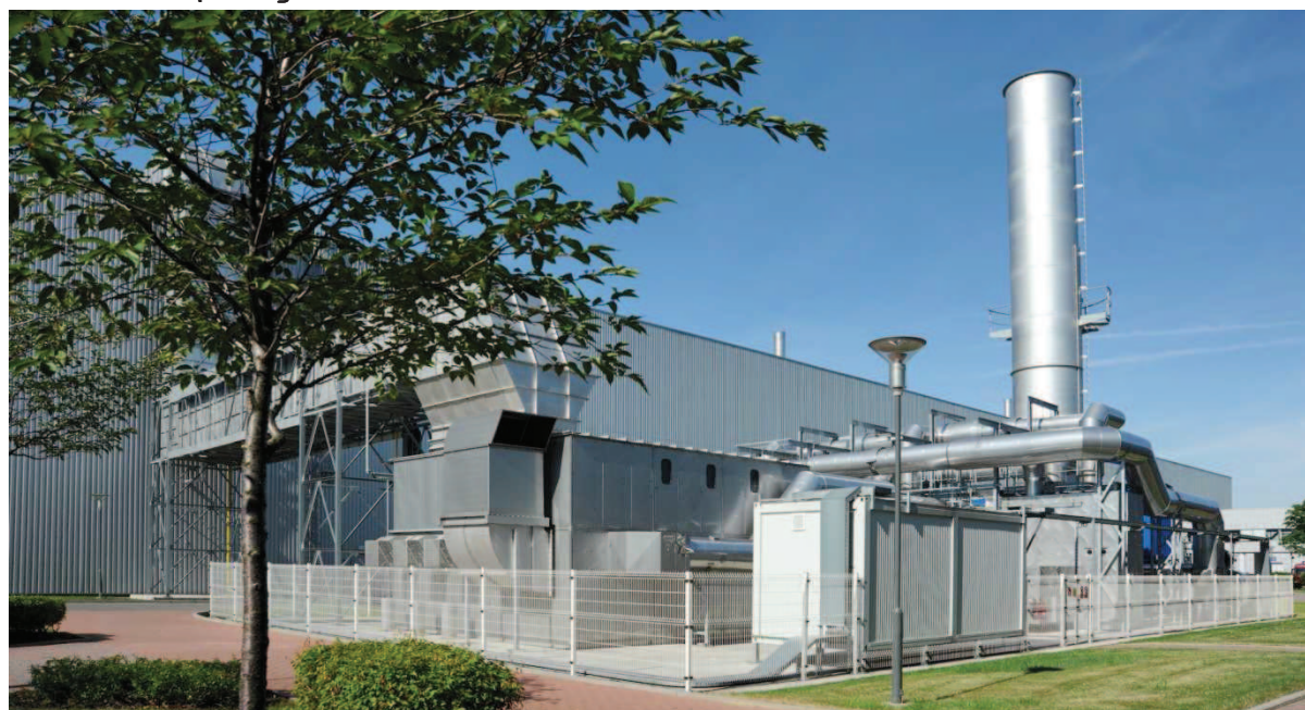
Obr.7 Zařízení pro regenerativní termickou oxidaci (RTO)
