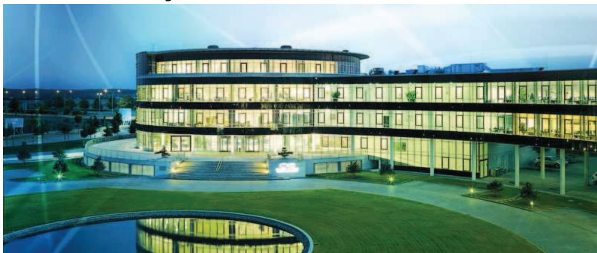
Obr. 3 Technické centrum Hyundai (Rüsselsheim)
