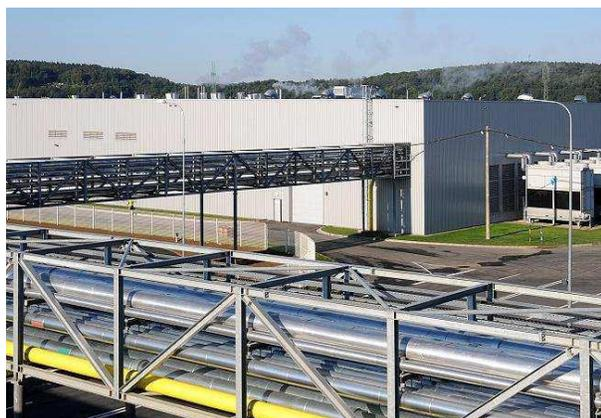
V objektu Energocentra je umístěna Úpravná vody, ve které se provádí úprava surové vody pro technologické účely. V úpravně se provádí třístupňová filtrace surové vody a čerpání upravené vody do odběrových míst. Voda je odebírána z vodovodního řadu.
