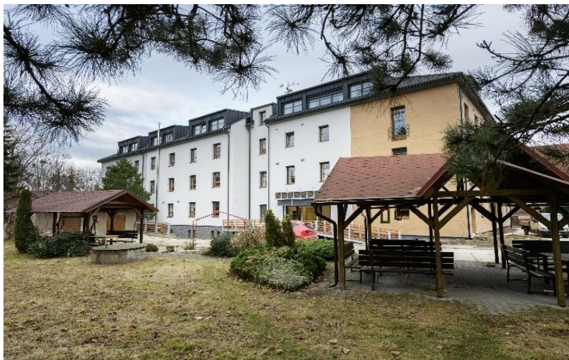
Obr.17 Domov pro seniory SAREPTA Komorní Lhotka
