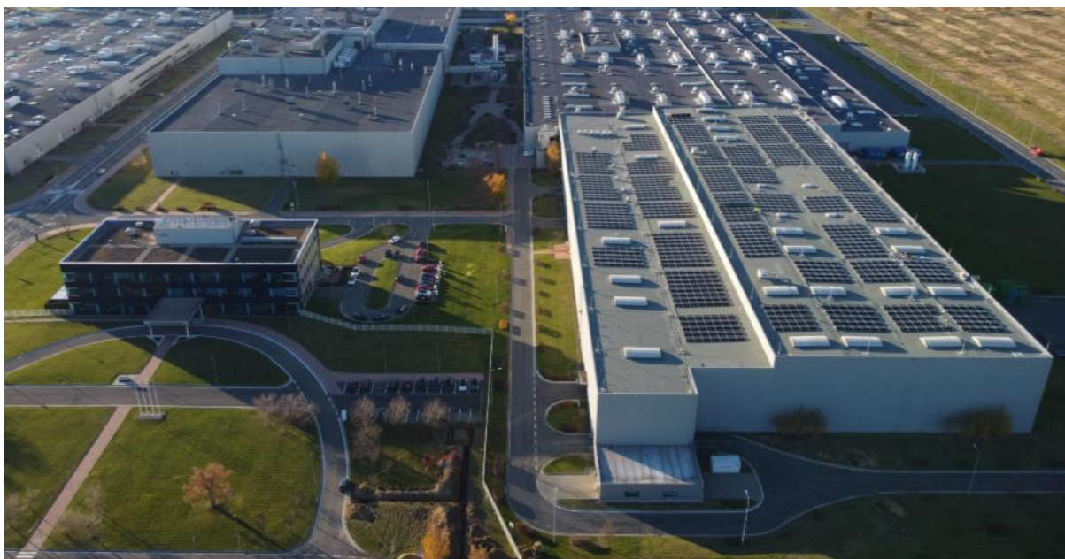
Obr. 10 fotovoltaická elektrárna na střeše Lisovny
